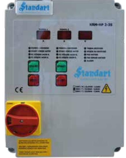
Resim 1 : İki pompalı basınç şalteri kontrollü panonun önden görünüşü
